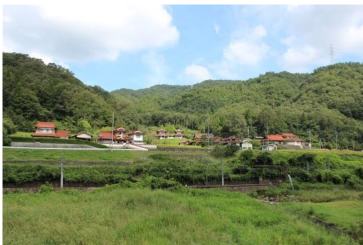
入野の国道432号線から見える線路の上を通る水路
